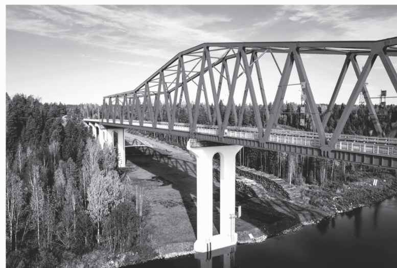
В Ленобласти продолжается строительство и ремонт мостов
