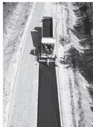
В планах на 2024 год — ремонт 200 км автодорог
